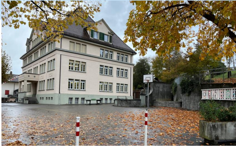
Denkmalgeschütztes Schulhaus und Brunnen
